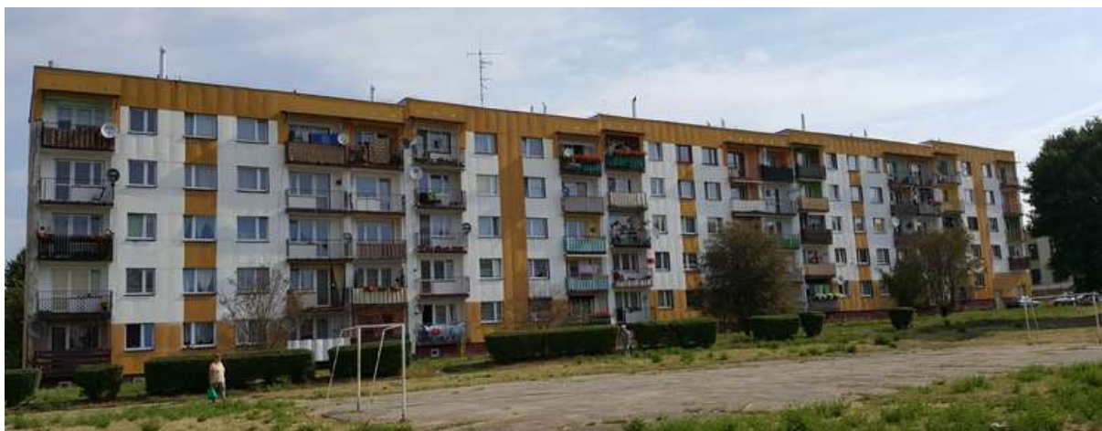
FOT. 2. ELEWACJA TYLNA
