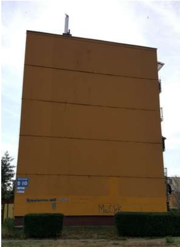
FOT. 3. ELEWACJA SZCZYTOWA
