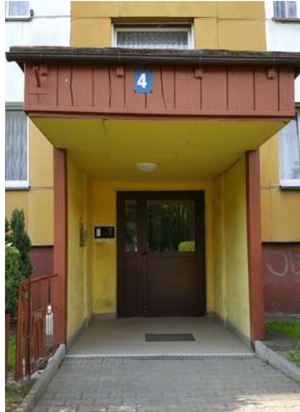
FOT. 4. DRZWI WEJŚCIOWE DO BUDYNKU
