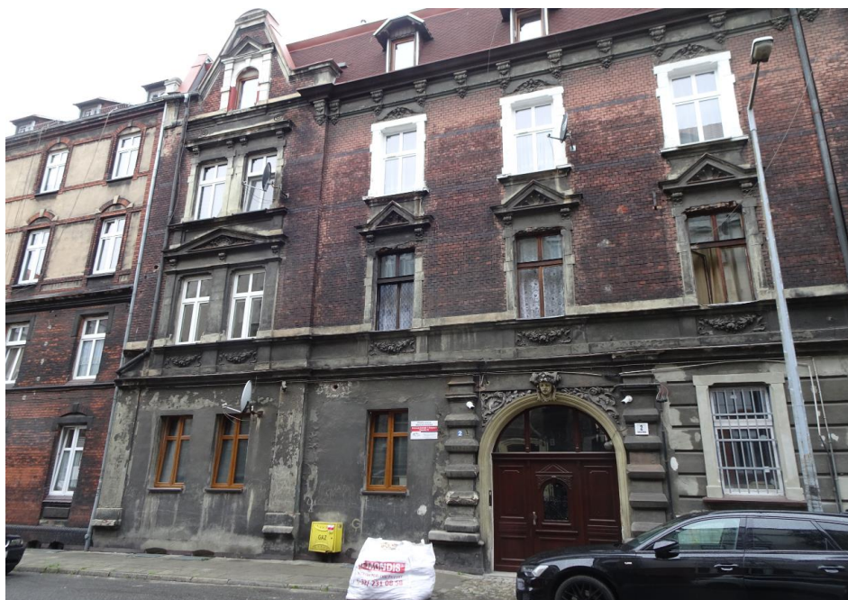
Fot. 1. Widok na elewację frontową [1.3]
