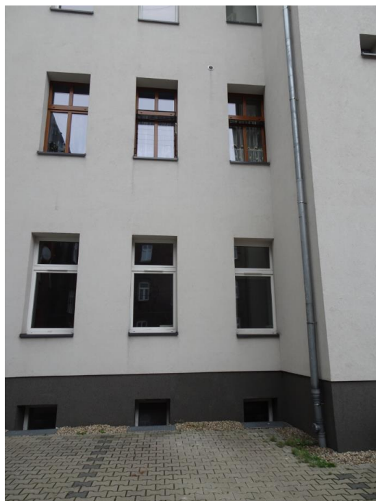
Fot. 2. Widok na elewację tylną [1.3]
