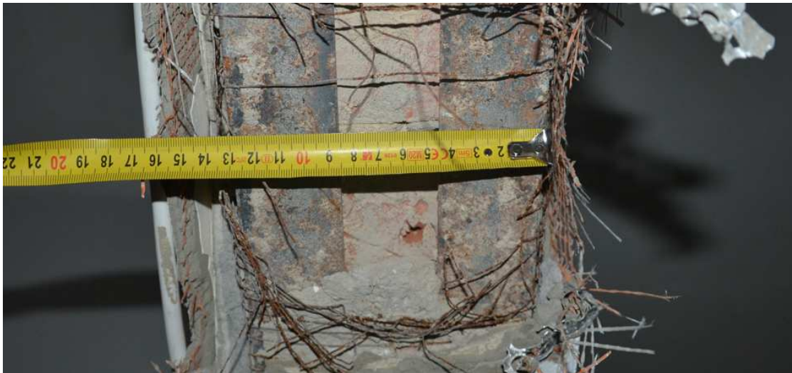
Fot. 2. Odkrywka profili podparcia fragmentu pozostawionej ścianki; podparcie 2L 45x45 mm [1.2].
