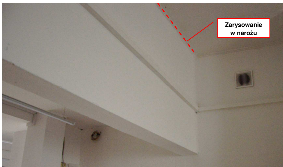
Fot. 3. Widok ogólny fragmentu pozostawionej ścianki pod stropem, oznaczenie miejsca zarysowania w narożu ścianka-strop świadczącego o deformacji ścianki [1.2].
