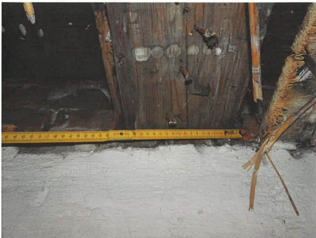
Rys. nr 22. Odslonięta belka drewniana stropu nad piwnicą przy ścianie zewnętrznej budynku frontowego od ulicy – szerokość ok. 20 cm, zmierzona wysokość ok.26 cm [1.4].
