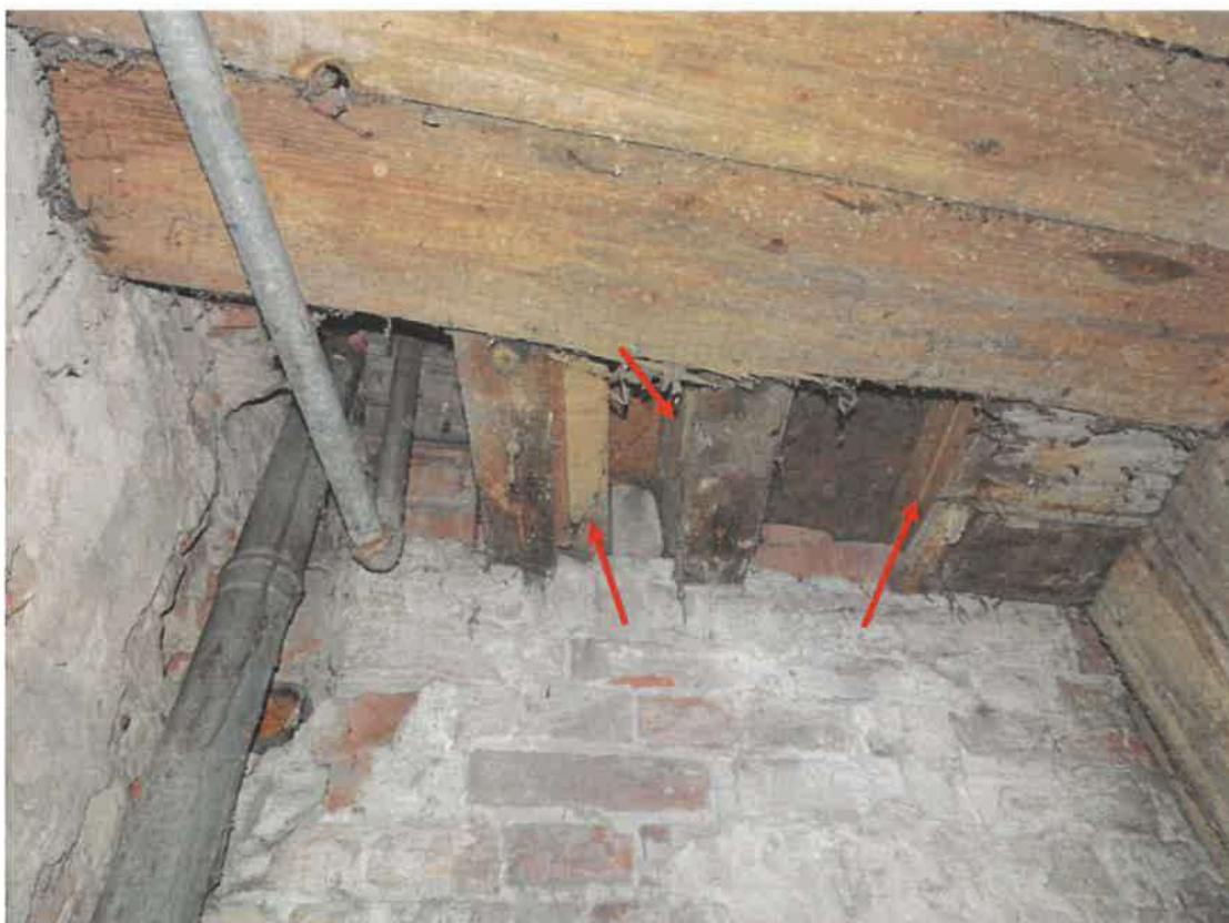
Rys. nr 23. Nowe belki stropu drewnianego oparte na ścianie zewnętrznej od podwórza budynku frontowego [1.4].
