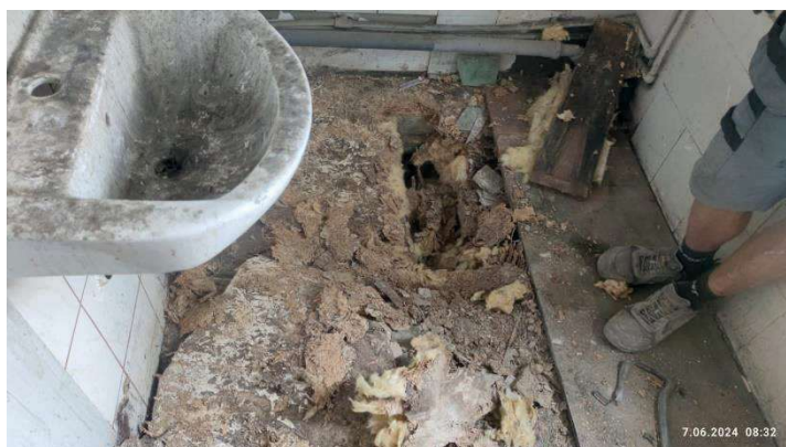
Fot. nr 2, 3, 4 – Widok stropu w łazience lokalu mieszkalnego nr 5
