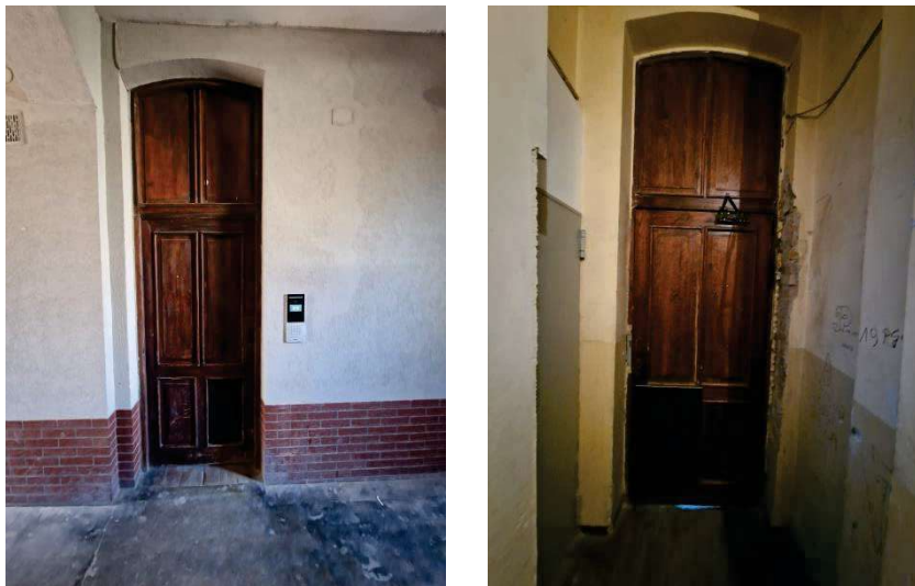
Fot. 12, 13 – Widok drzwi wejściowych do klatki schodowej
