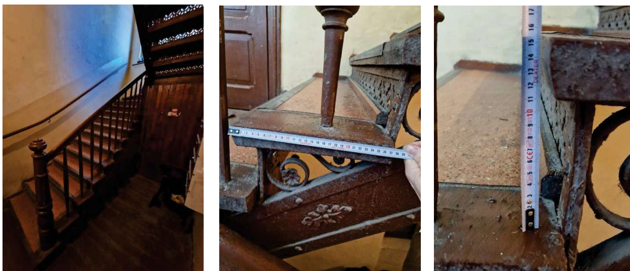
Fot. 14, 15, 16 – Widok schodów od strony wejścia
