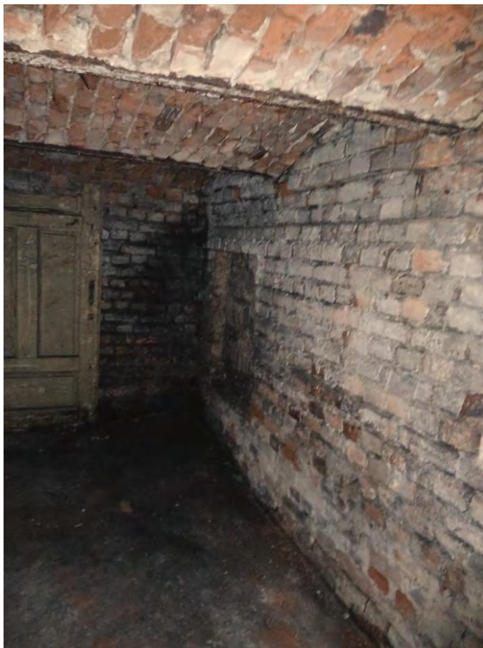
Fot. nr 11. Jedno z pomieszczeń piwnicznych budynku frontowego [1.3]
