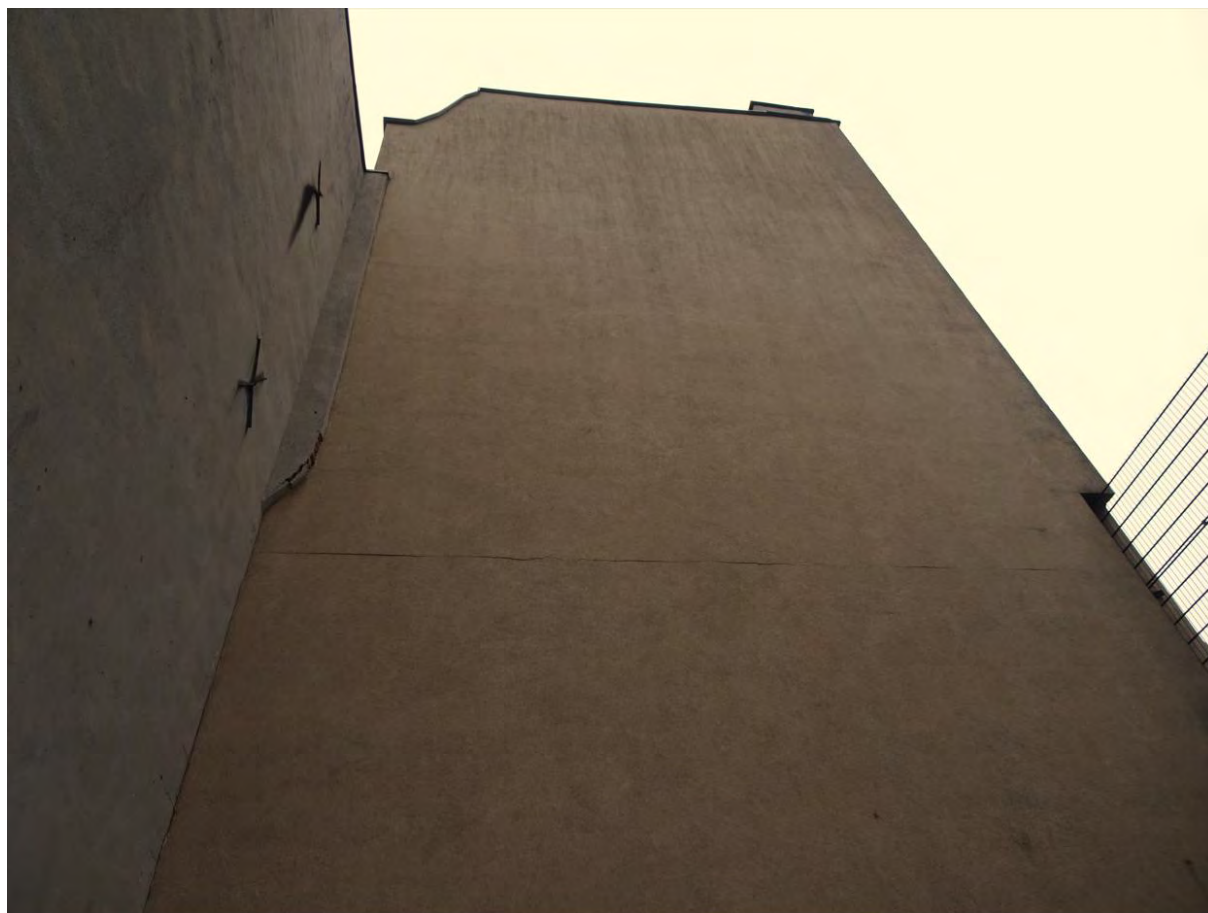
Fot. nr 8. Widok północno – zachodniej ściany szczytowej budynku oficyny [1.3].
