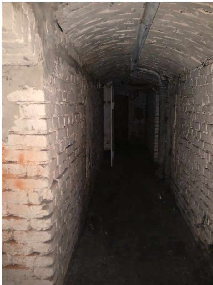
Fot. nr 10. Ogólny widok korytarza piwnicznego budynku frontowego [1.3]
