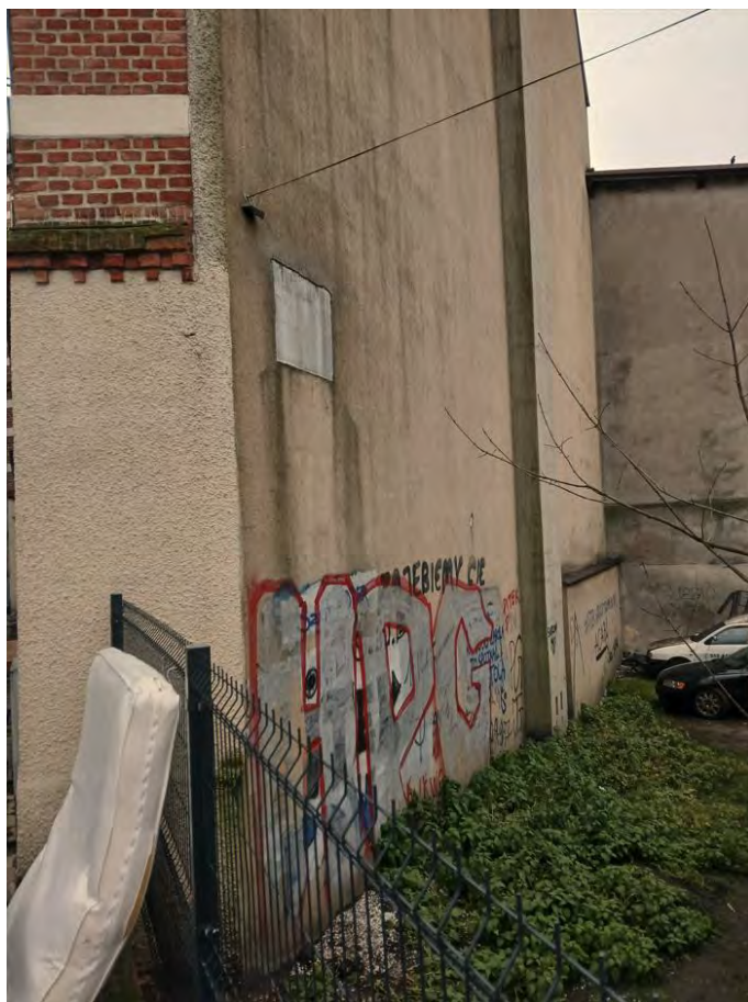
Fot. nr 4. Fragment elewacji północno – zachodniej budynku frontowego [1.3].
