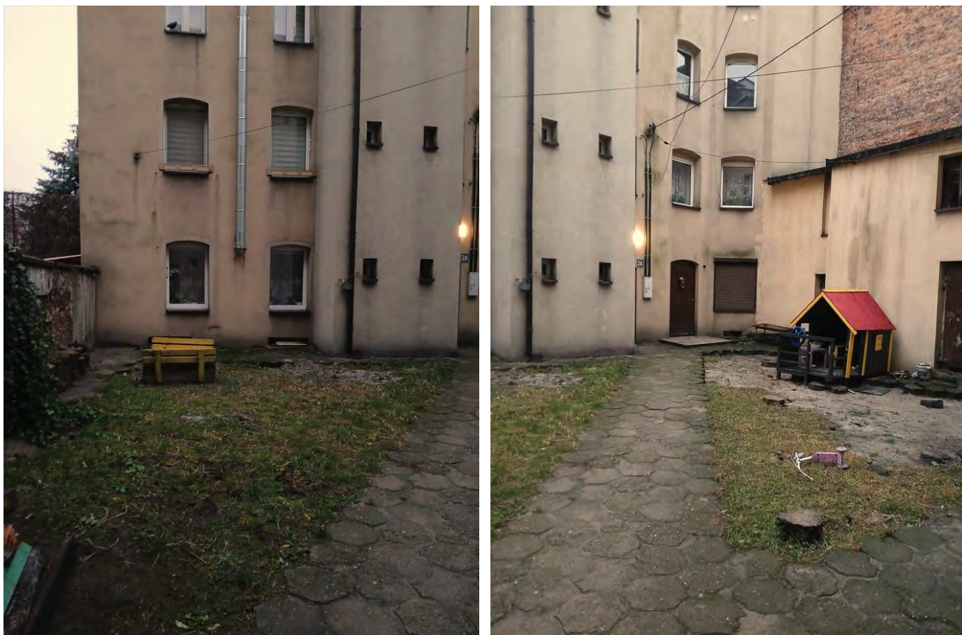
Fot. nr 6,7. Elewacja północno – wschodnia budynku oficyny [1.3].
