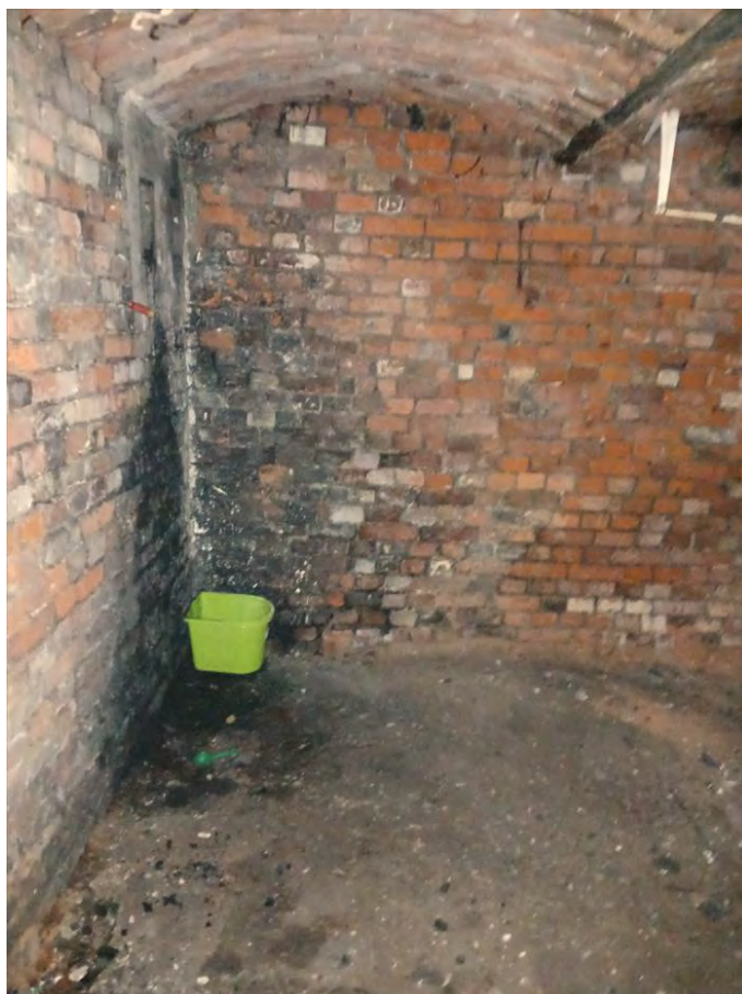
Fot. nr 13. Jedno z pomieszczeń piwnicznych budynku oficyny [1.3]
