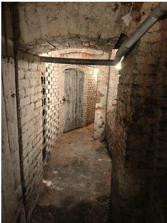
Fot. nr 12. Ogólny widok korytarza piwnicznego budynku oficyny [1.3]
