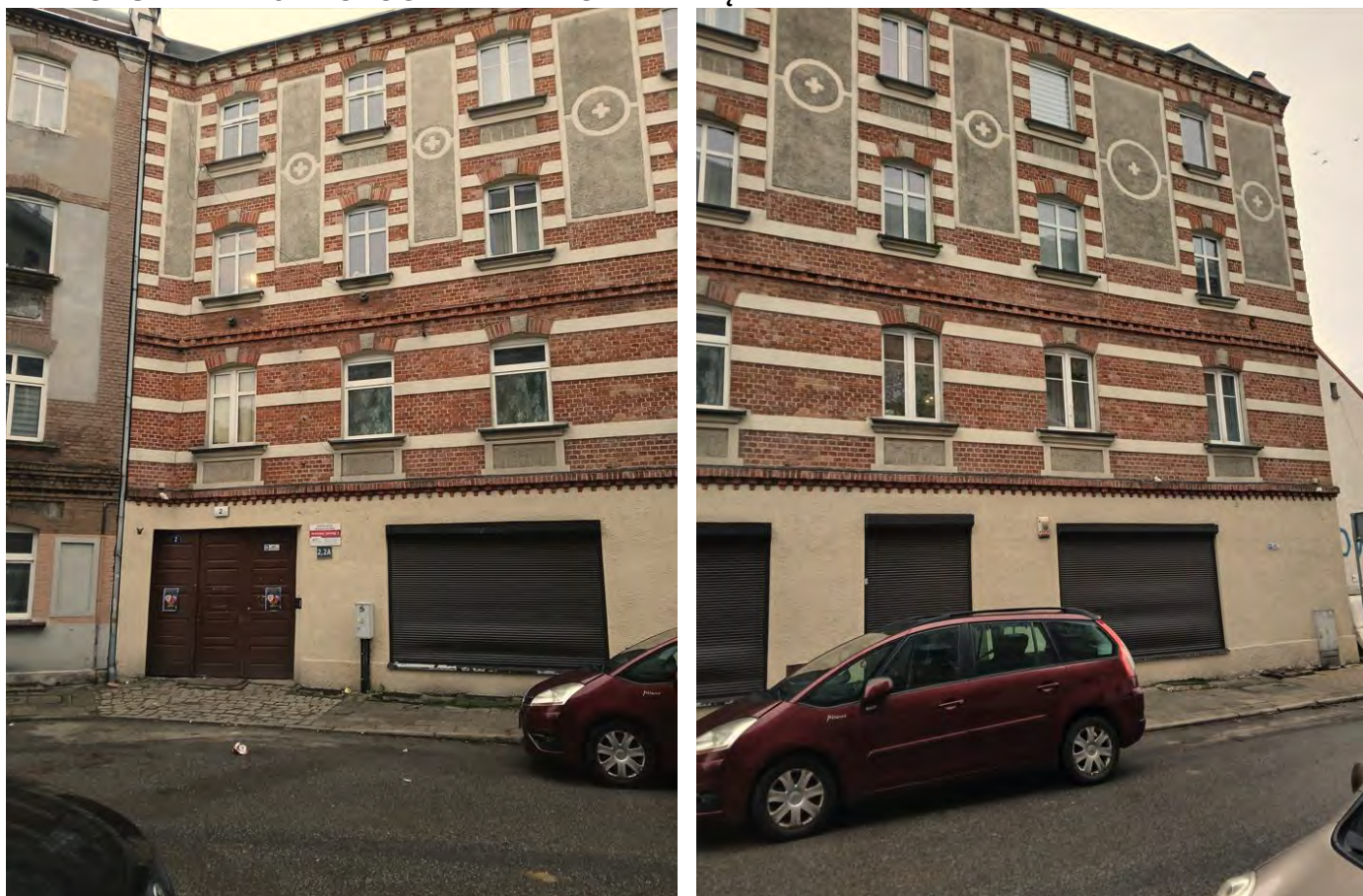
Fot. nr 2,3. Widok ogólny elewacji frontowej [1.3].
