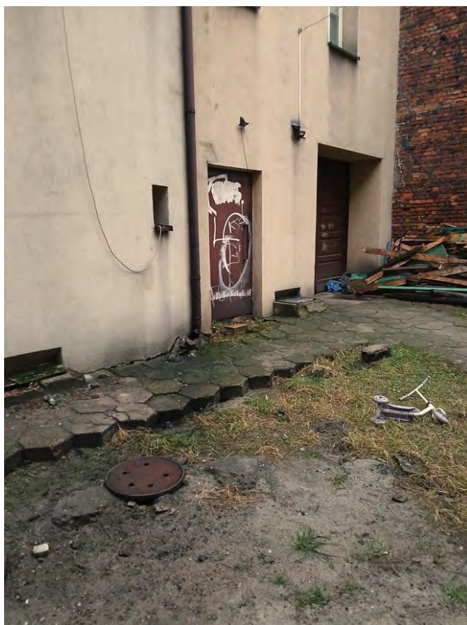
Fot. nr 5. Fragment elewacji południowo – zachodniej budynku frontowego [1.3].
