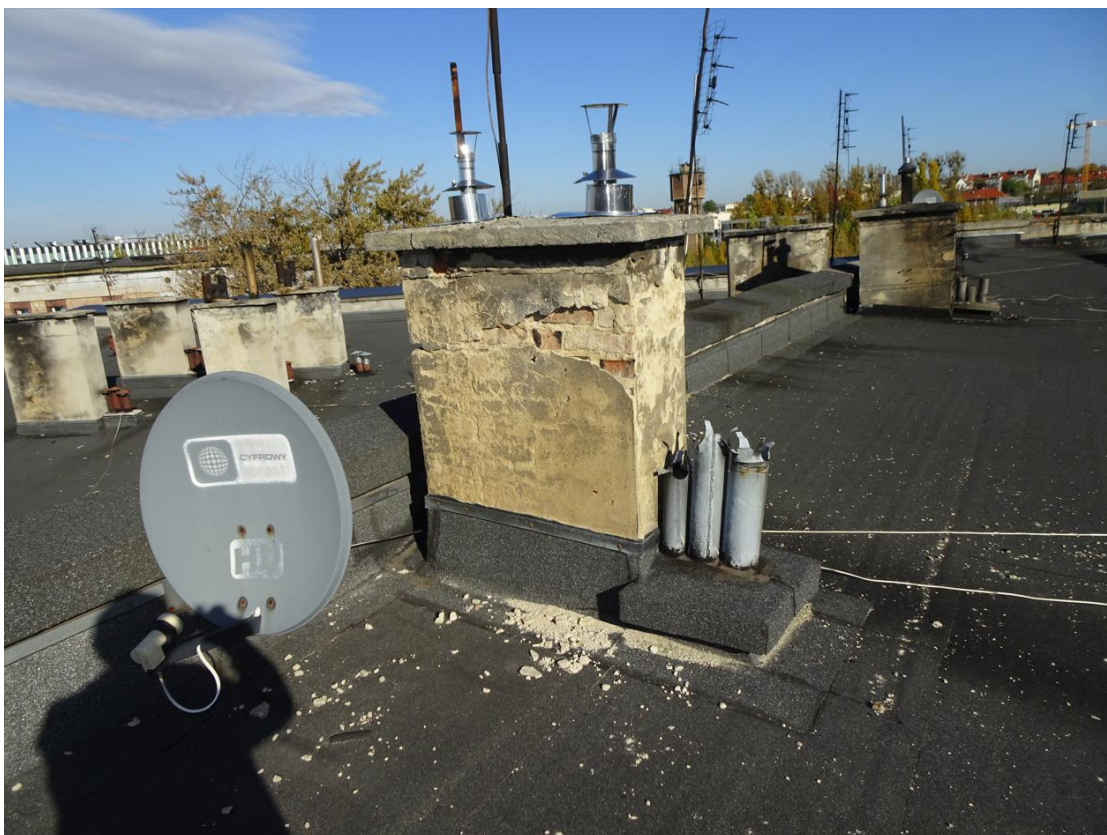
Rys. nr 17. Odsłonięcie i ubytki tynków na kominie, w tle widoczne zabrudzenie powierzchni komina [1.4].
