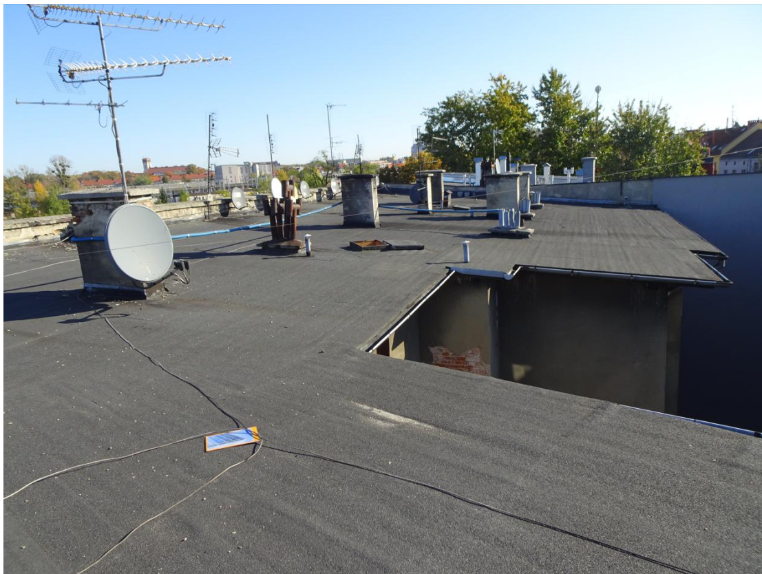
Rys. 16. Widok ogólny dachu budynku frontowego – uszkodzenia wypraw tynkarskich na kominach, korozja nasad wentylacyjnych [1.4].
