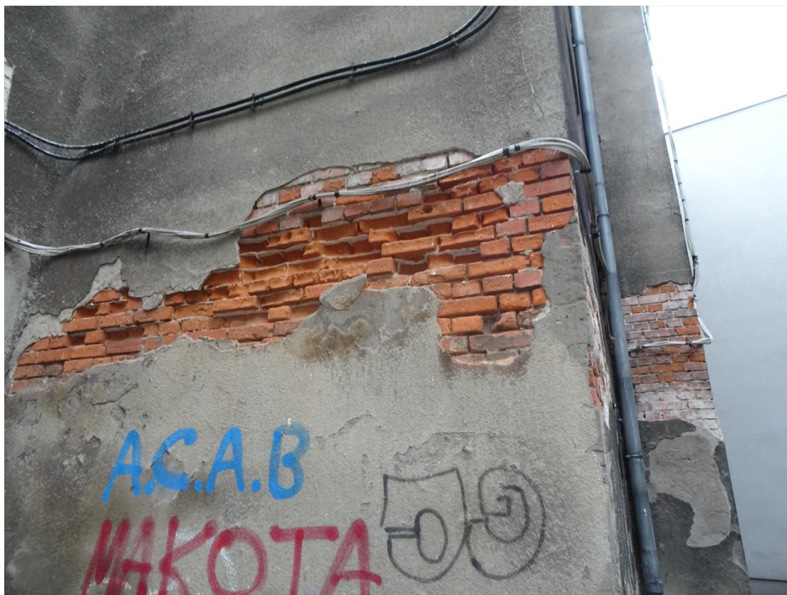
Rys. 12. Znaczne uszkodzenie fragmentu ściany ceglanej – ubytki cegieł, łuszczenie bocznych płaszczyzn cegieł, brak spoinowania. [1.4].
