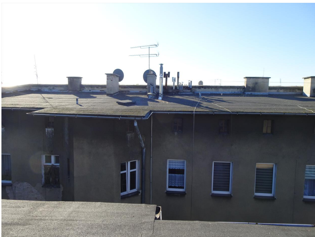
Rys. nr 19. Ogólny widok dachu budynku oficyny – widoczne ślady zawilgocenia kominów, zabrudzenie powierzchni, ubytki wypraw tynkarskich na kominów, zabrudzenia rury spustowej i fragmentów elewacji odchodami ptasimi. Miejscowe zanieczyszczenie pokrycia dachowego [1.4].
