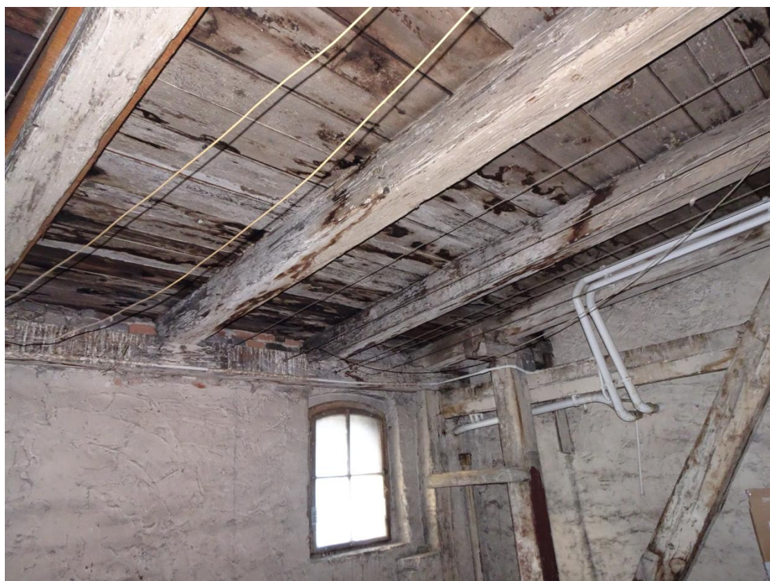
Rys. nr 21. Ślady zawilgocenia deskowania i krokwi dachowych [1.4.].
