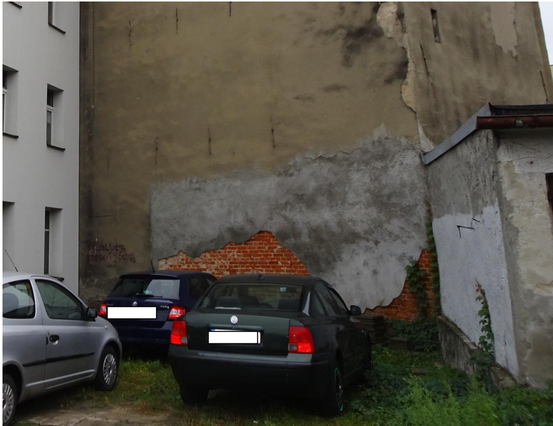
Rys. 14. Zachodnia ściana budynku głównego – ubytki tynku w miejscu uzupełnienia wyprawy tynkarskiej [1.4.].
