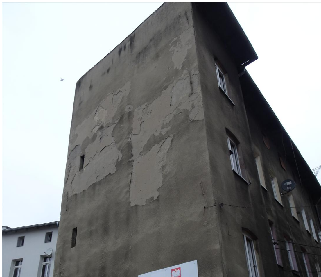
Rys. 13. Ubytki i odspojenie tynków zewnętrznych na południowo – zachodniej ścianie budynku frontowego [1.4].
