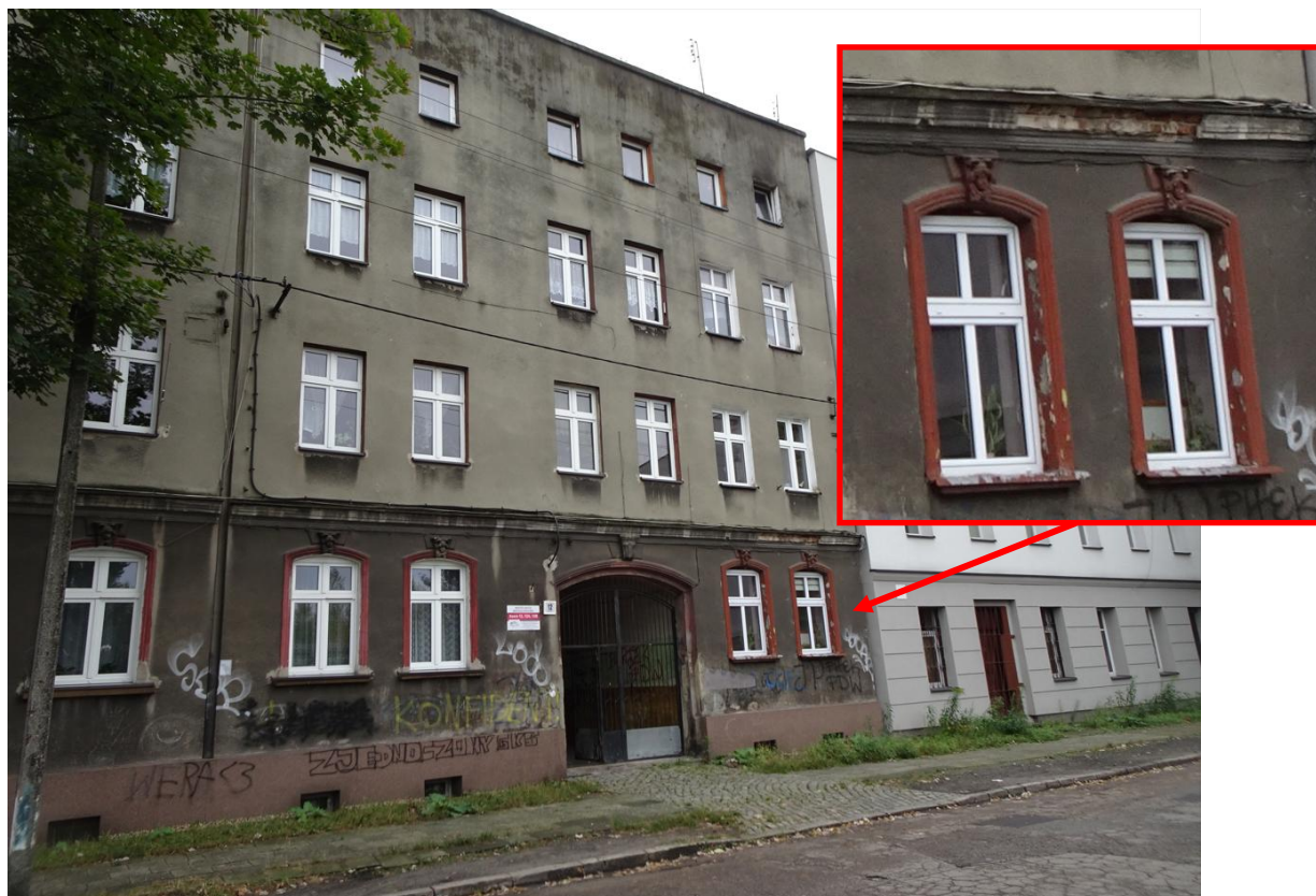
Rys. 10. Elewacja frontowa – napisy na elewacji, zabrudzenie tynku, widoczne ślady zawilgocenia tynku, ubytki tynku na fragmencie gzymsu nad parterem, odspojenie powłok malarskich na opaskach wokół okiennych, odspojenia powłoki malarskiej na obróbkach blacharskich parapetów okien parteru [1.4].
