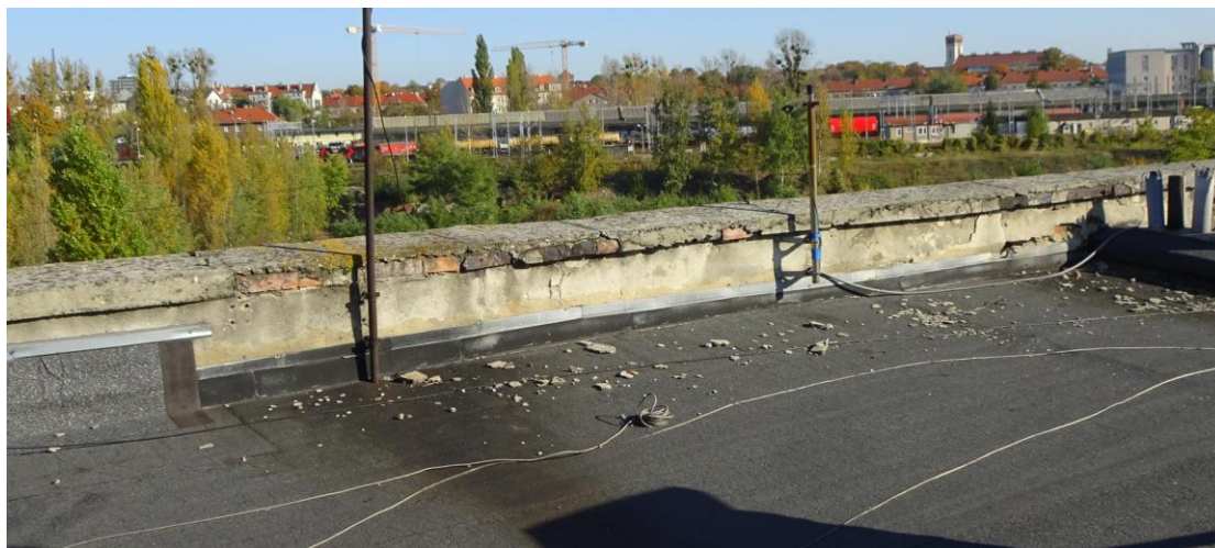
Rys. nr 18. Ścianka attyki – brak zakończenia obróbką blacharską, ubytki tynku na powierzchni ścianki i zwieńczenia attyki, zalegające kawałki wyprawy tynkarskiej na powierzchni dachu; widoczne ślady zawilgocenia pokrycia [1.4].
