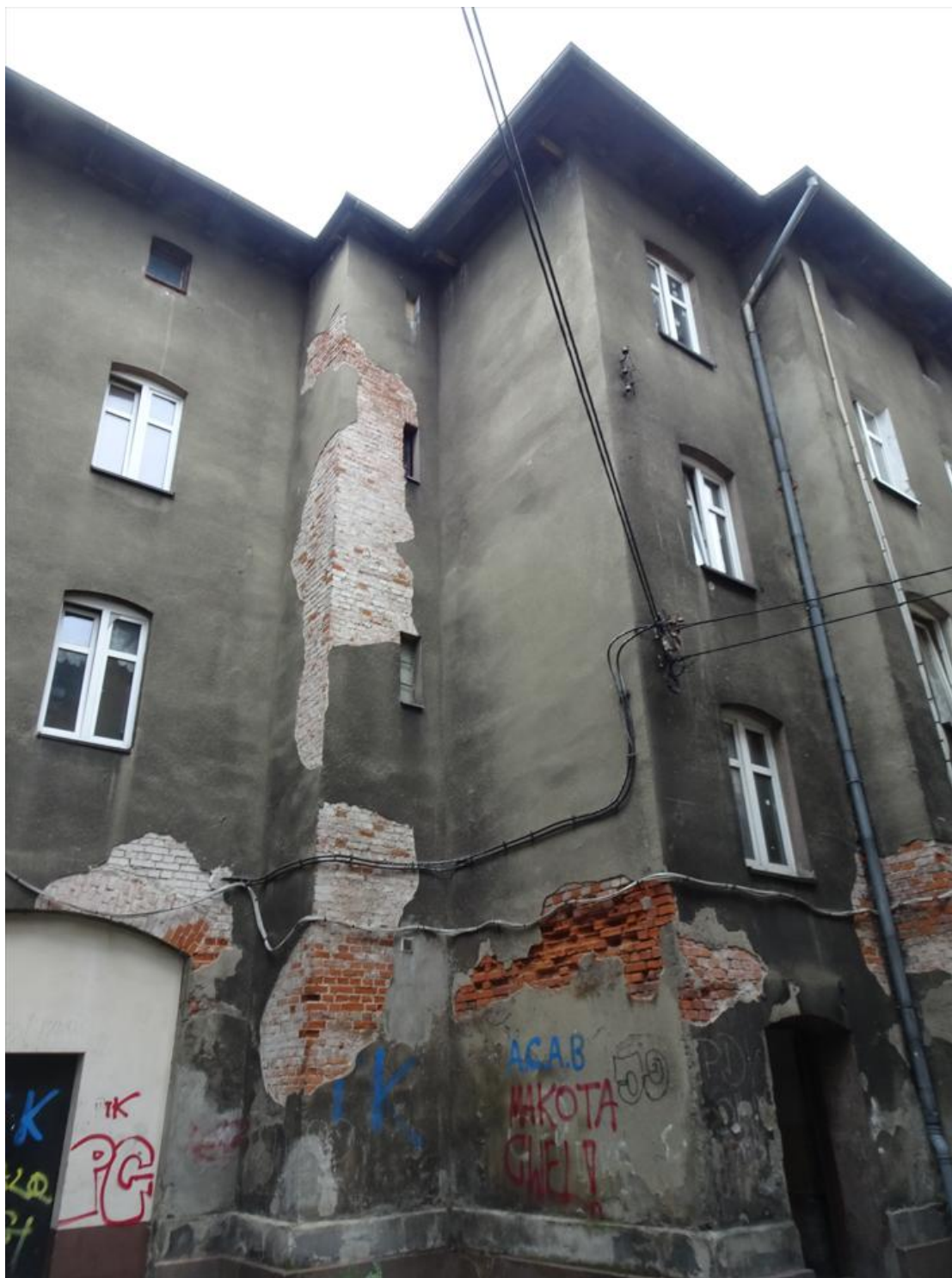
Rys. 11. Destrakcja elewacji południowej budynku głównego – odspojenie fragmentów tynków, ubytki cegieł, złuszczenie powierzchni cegieł. [1.4.]
