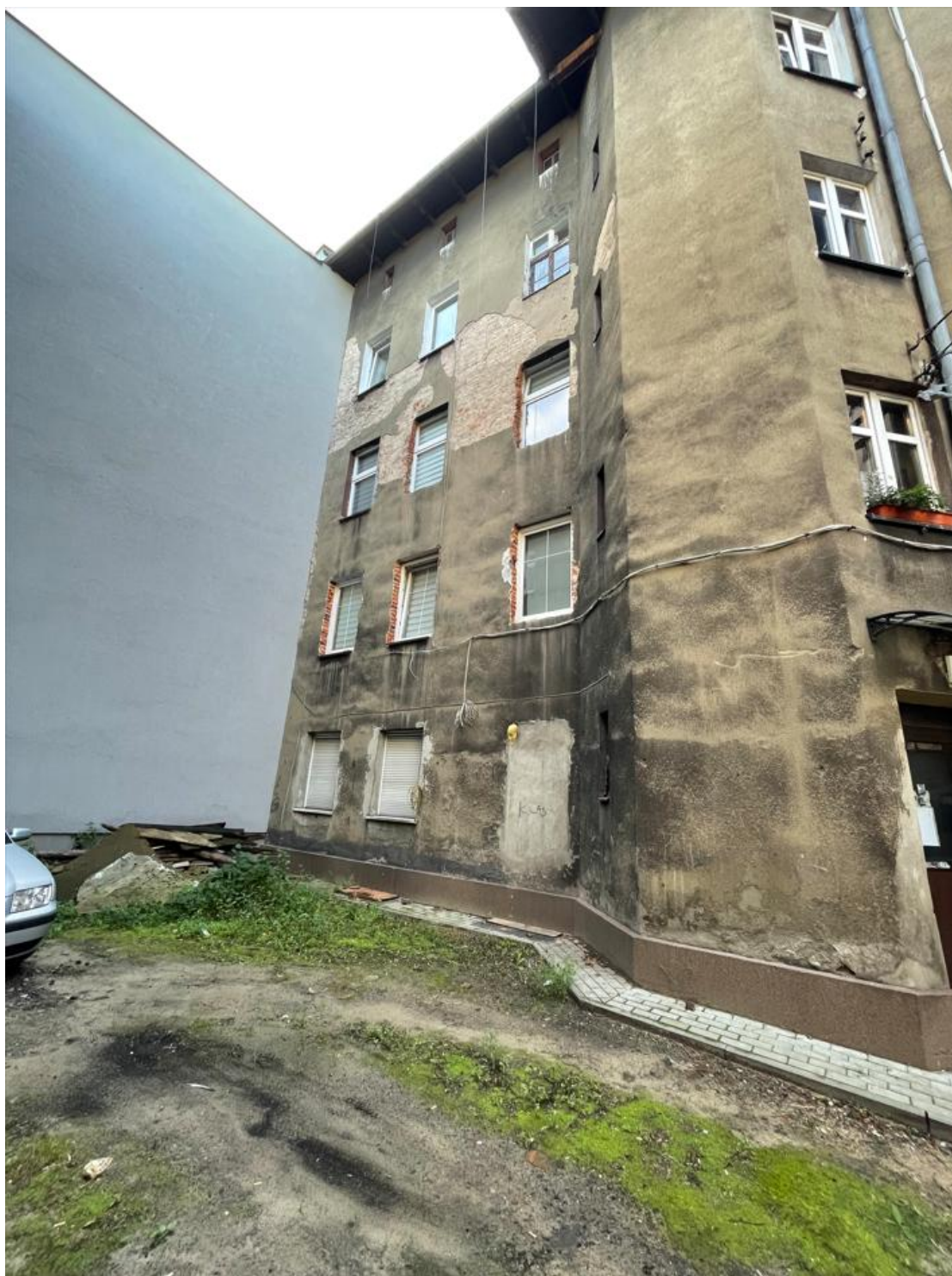
Rys. 15. Fragment elewacji północnej budynku oficyny – zabrudzenie elewacji, odspojenia i ubytki tynków zewnętrznych [1.4].
