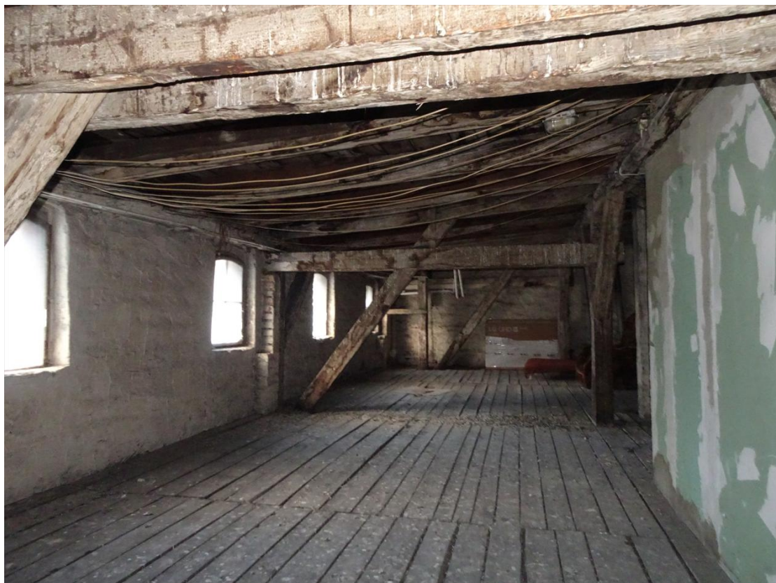
Rys. nr 20. Ogólny widok przestrzeni strychowej – widoczne ślady zawilgocenia drewnianych elementów konstrukcji dachu. Zaleganie ptasich odchodów na deskach podłogowych strychu [1.4.].
